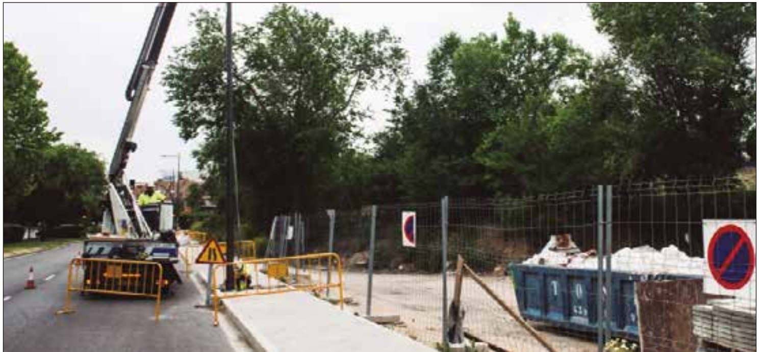
Arrancan las obras en la Avenida Juan Pablo II y en la calle Antonio Becerril de Pozuelo. / Prensa Pozuelo
